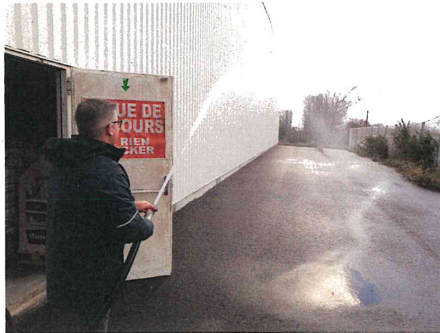
Photo 6 : Test concluant de fonctionnement d'un RIA
